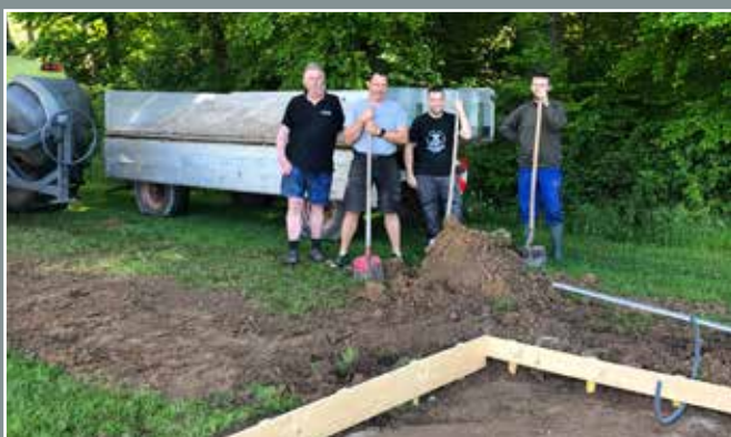
Charles Strasser, Mathieu Maréchal, Yann Brencklé et Quentin Goetz ont mis la main à la pâte pour installer le nouvel équipement
